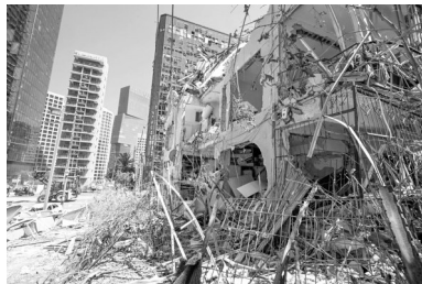
这是6月19日在以色列中部拉马特甘拍摄的在导弹袭击中被毁的建筑。
