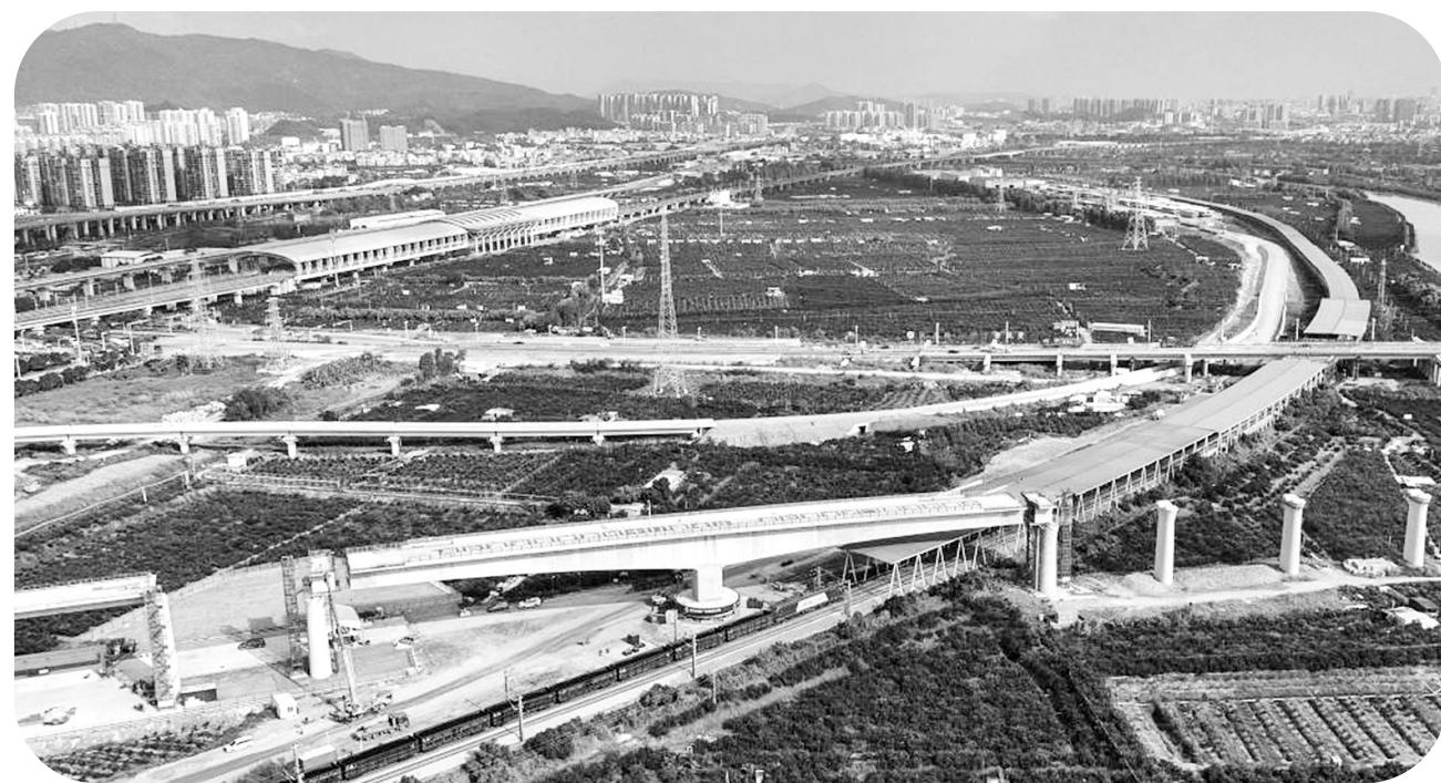
10月10日凌晨，由中铁二十五局承建的深江铁路广中江特大桥跨广珠货运铁路转体桥成功转体，该转体桥重达11216吨、跨度160米，位于深江铁路关键控制性工程广中江特大桥跨虎跳门段。
