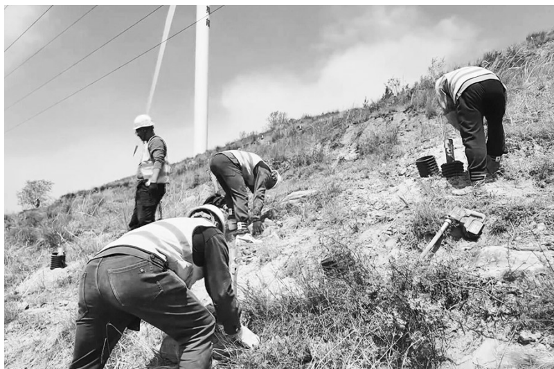
项目施工现场 资料图
