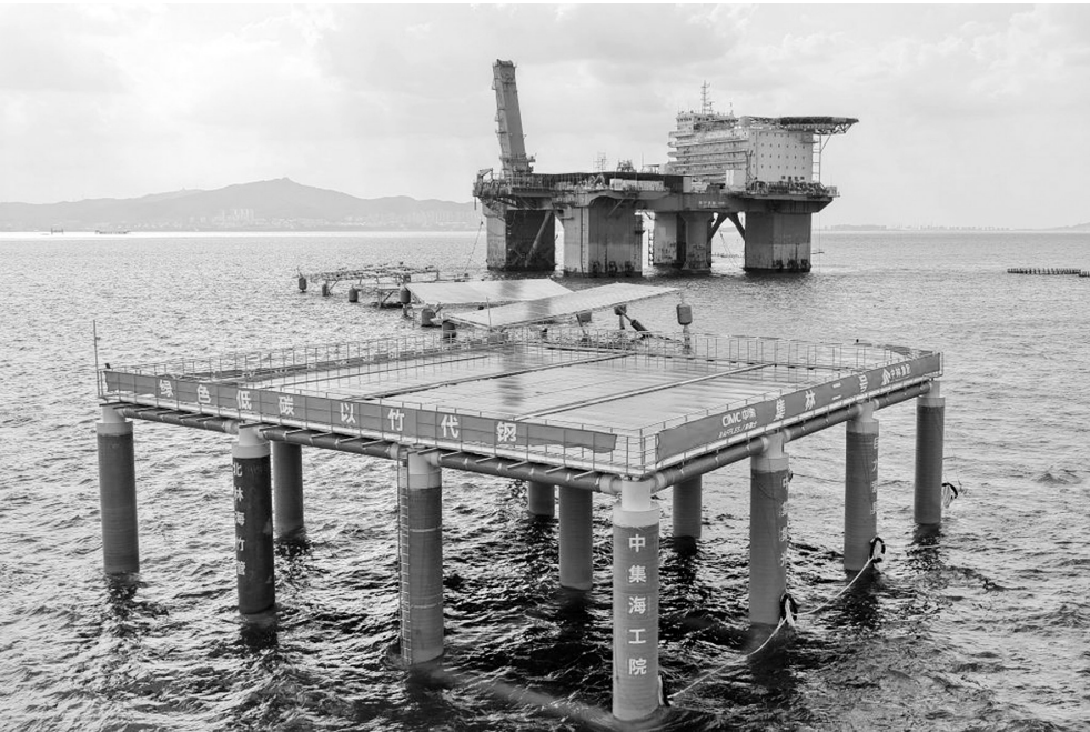
8月1日，百千瓦级竹基海上光伏平台“集林二号”在山东烟台海上光伏实证检测基地完成安装。相较于传统钢结构及高密度聚乙烯浮体，该平台能够降低对海洋生态环境的影响，实现“绿电绿造”。
