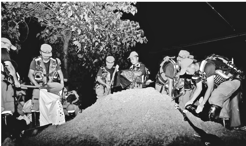
在河南省平顶山市郏县长桥镇,抢险人员正在堤上奋战。记者 郝源 摄
