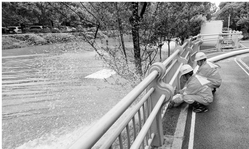
8月11日,抢险人员在上海市松江区进行排水作业。受访单位供图
