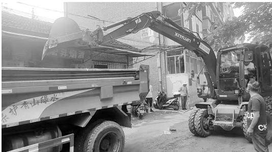
路面施工 记者 曹伟 摄
